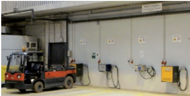
Bild 6-1: Sicherheitskennzeichnungen an den Ladepunkten innerhalb einer Ladestation
