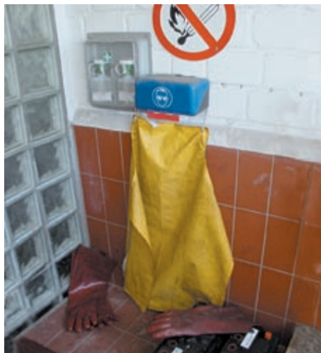
Bild 7-6: Bereitgestellte PSA in einer Batterieladestation
